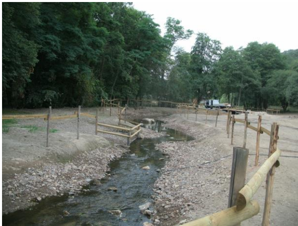
Remise en fond de vallée de la Maure
