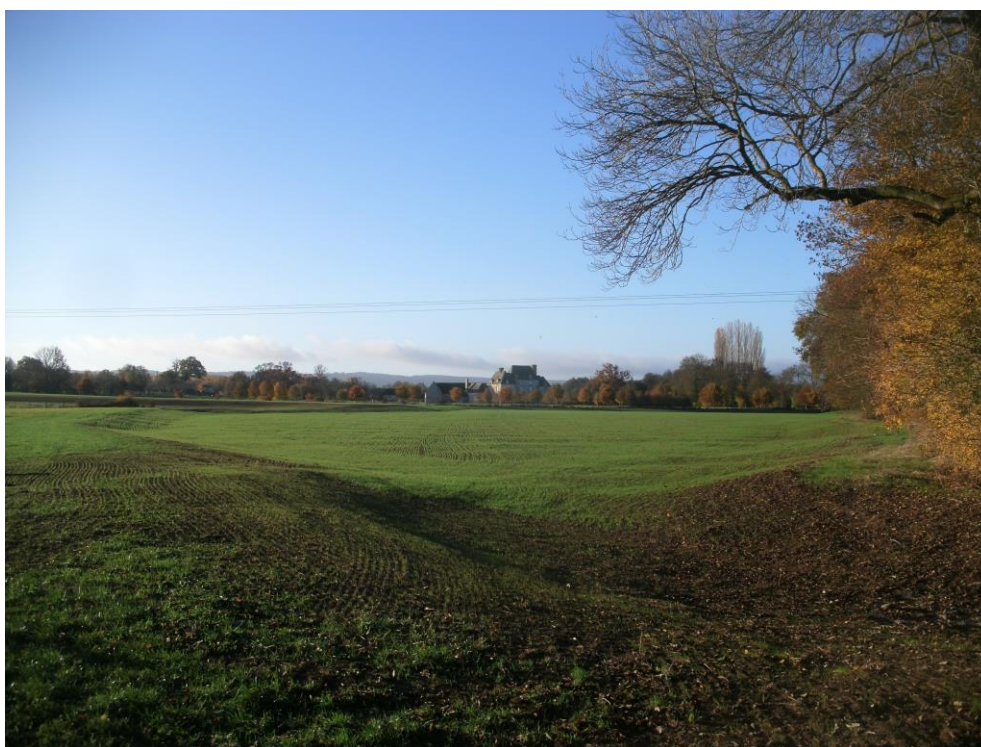
Champ d'expansion de crue réalisé dans le lit majeur de la Sennevière et dont le chantier s'est terminé en septembre 2019
